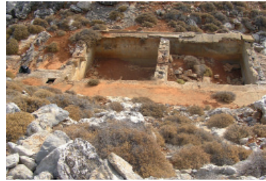
Εικ. 24 : Σύγχρονο υδρομαστευτικό έργο (Ε. Θέου)
