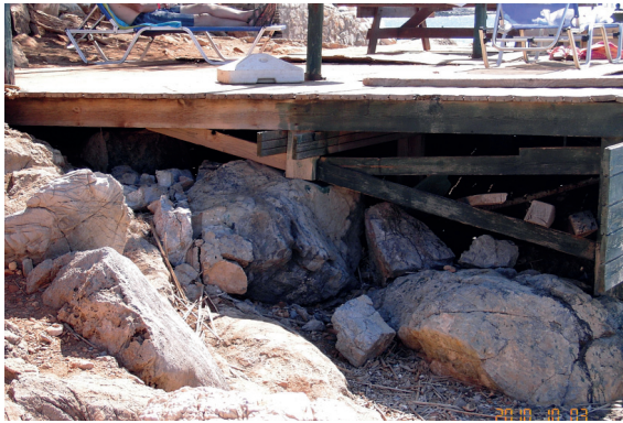
Εικ. 27 : Θεμέλιο παράκτιου μινωικού κτηρίου υπό πρόχειρη ξυλοκατασκευή (Κ. Κόπακα)
